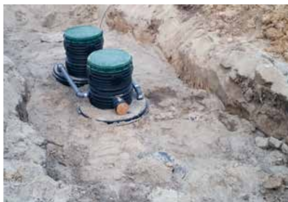
Oczyszczalnia actibio podczas montażu.
